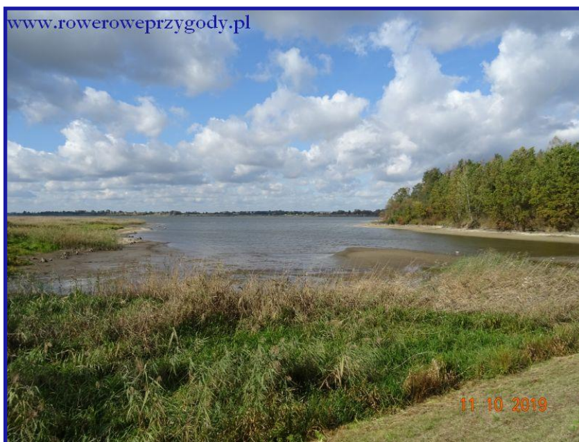
Zdjęcie nr 14 – Północna część zbiornika zaporowego Nielisz.
