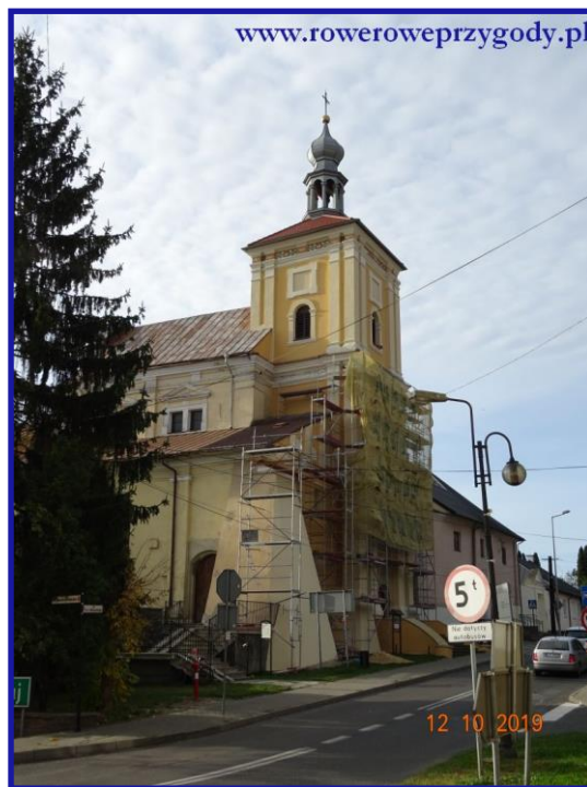
Zdjęcie nr 29 – Remontowany obecnie budynek kościoła pw. Św. Katarzyny w Szczepieszynie.
