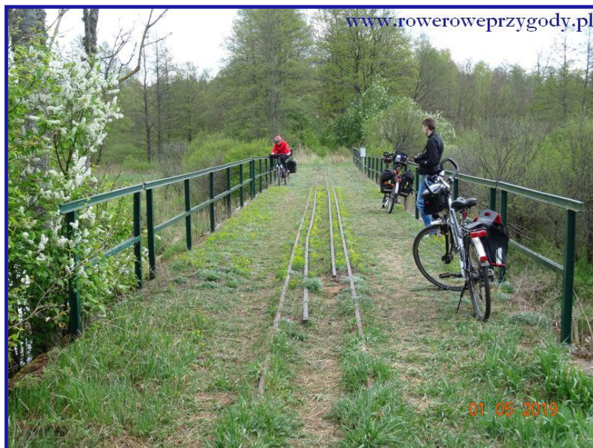
Zdjęcie nr 6 - Jeden z dwóch mostów nad rzeką Narewką (most kolejki wąskotorowej).
