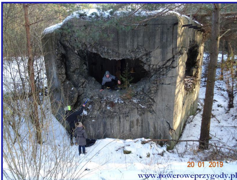
Zdjęcie nr 15 - Wysoki, dwukondygnacyjny schron nr 9.
