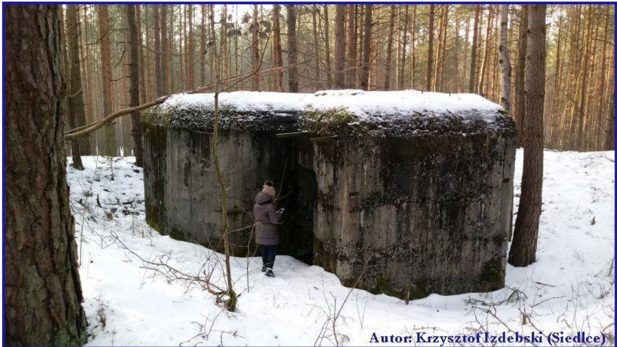
Zdjęcie nr 14 - Dobrze zachowany bunkier nr 8.
