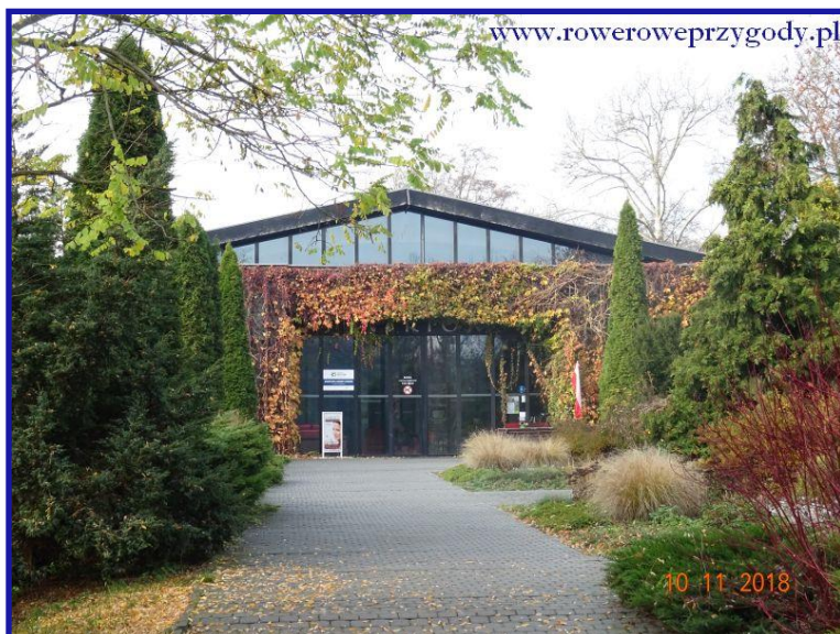
Zdjęcie nr 12 - Widok na główne wejście kompleksu wodnego - Atrium.
