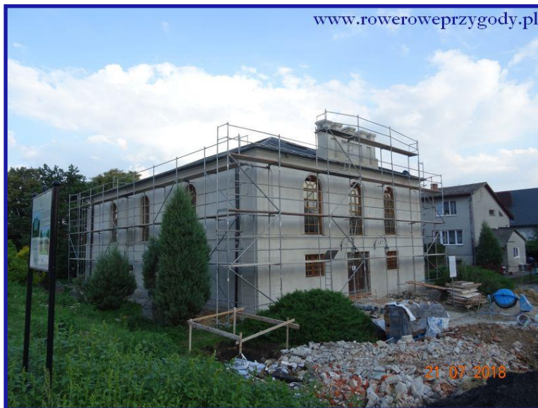
Zdjęcie nr 18– Remontowana obecnie wojsławicka synagoga zwana Nową.
