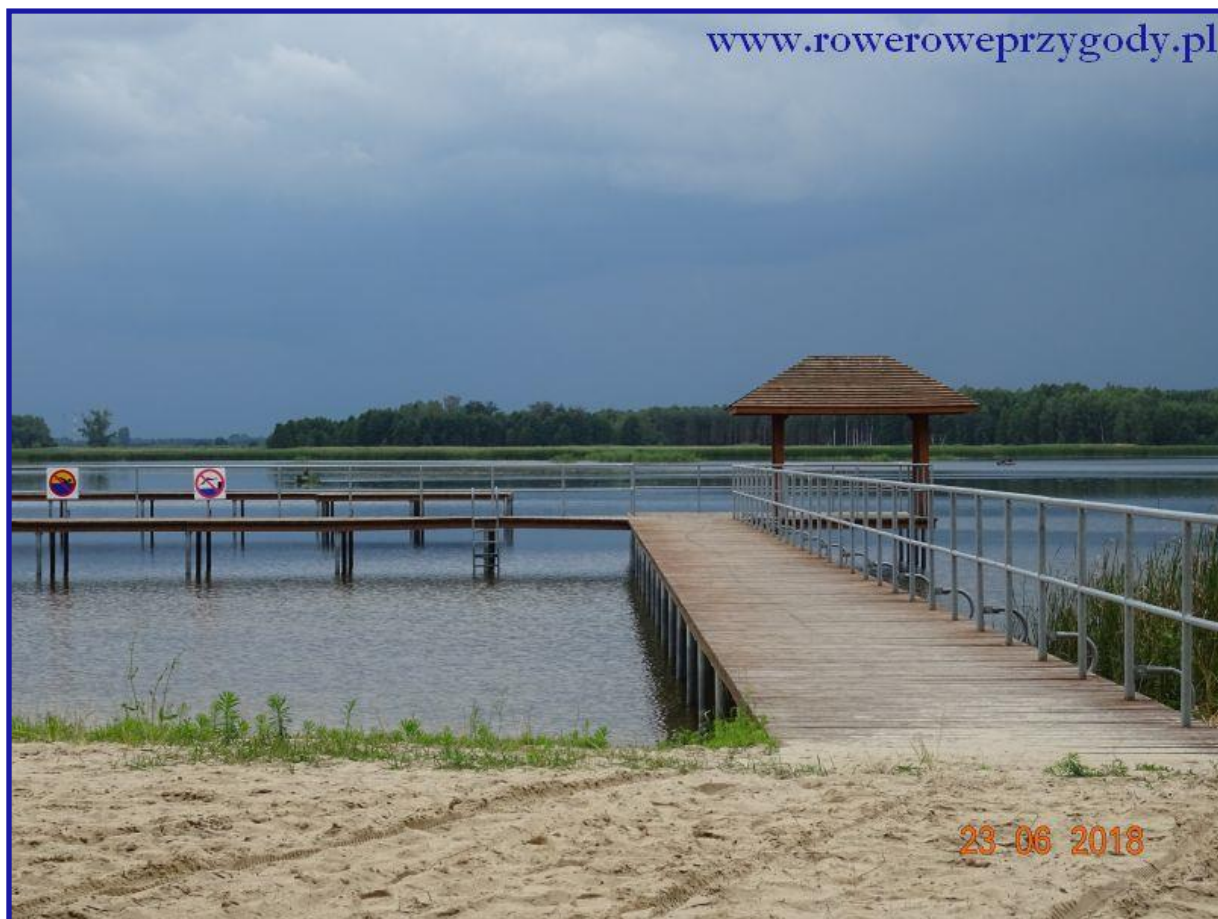
Zdjęcie nr 7 - Miejsce rekreacji dla okolicznych mieszkańców – zalew w Husynnem.
