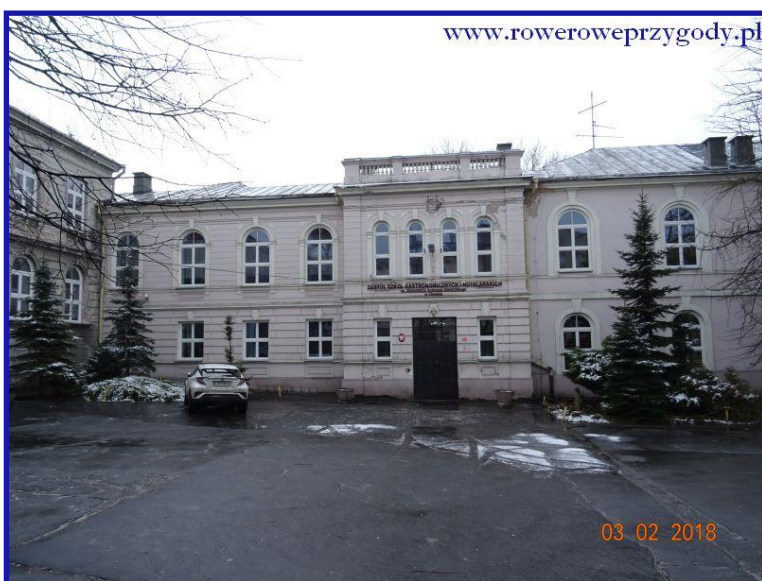
Zdjęcie nr 17 - Dawny budynek klasztoru Reformatorów, obecnie placówka edukacyjna.
