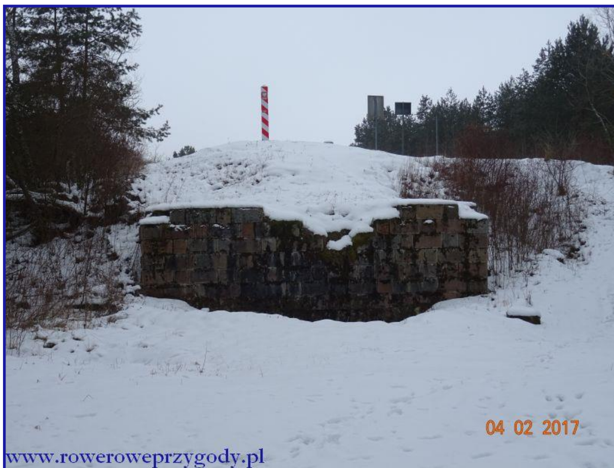
Zdjęcie nr 8 – Zakończenie nasypu kolejowego linii Chełm-Włodawa nad rzeką Bug w okolicy Orchówka.
