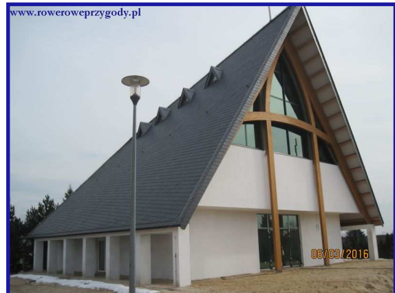
Zdjęcie nr 16 – Nowo budowany kościół katolicki w Kobylanach
